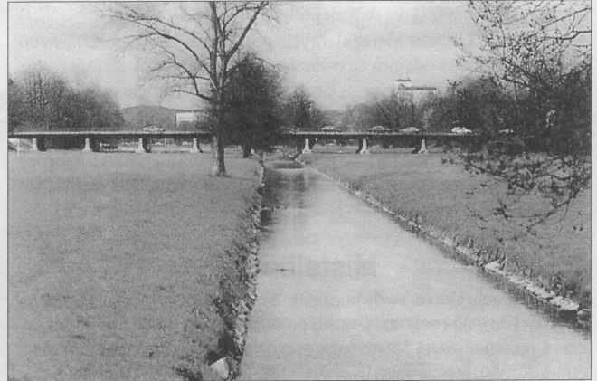
Zabudowane koryto Pfettrach przed renaturalizacją [1].
