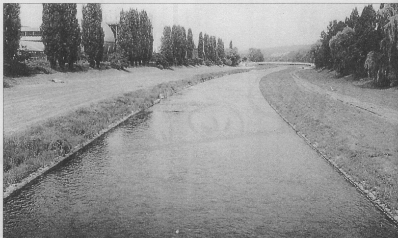
Spośród wielu rzek w Badenii, również Enz została zabudowana na początku stulecia do profilu podwójnego trapezu. Skarpy koryta wody średniej umocnione były za pomocą brukowanych kostek. Fot. Maerzke [2].
