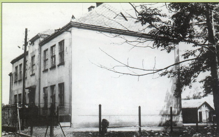
Na fotografii budynek szkoły przed rozbudową
