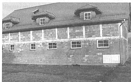
Budynek LKS PIONIER w Pisarzowicach (w budowie).
