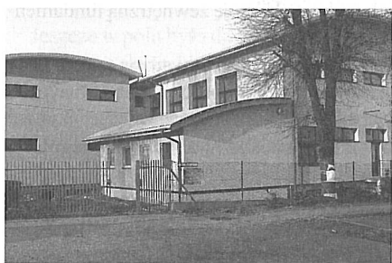
Budynek Szkoły Podstawowej i Gimnazjum w Pisarzowicach w trak- cie modernizacji.
