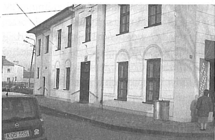
Dom Ludowy w Hecznarowicach po odnowieniu.
