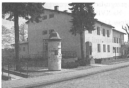
Zmodernizowany Ośrodek Zdrowia i Przedszkole w Dankowicach.
