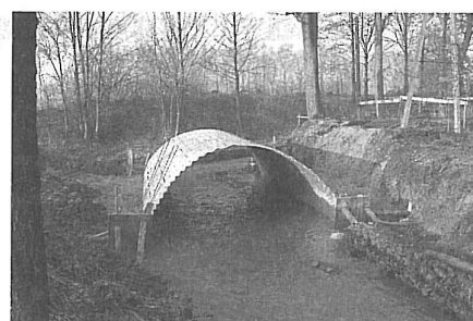
Przebudowa mostu na potoku Słonica w ciągu ul. Starowiejskiej w Pisarzowicach.
