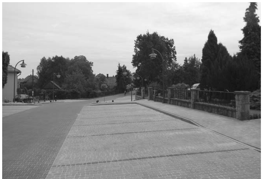
Wyremontowany parking przy kościele w Wilamowicach
