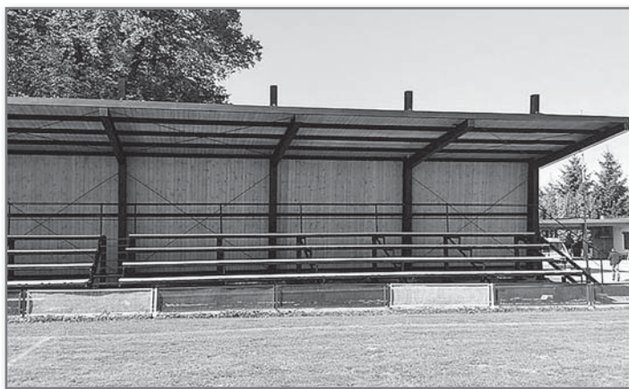
Zadaszenie nad trybuną na obiekcie LKS „Pionier”
