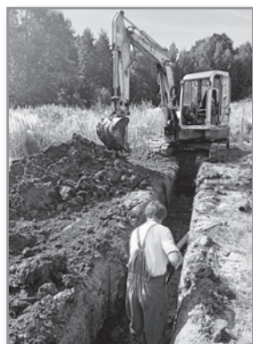
Budowa kanalizacji ul. Nowy Świat Zasole Bielańskie
