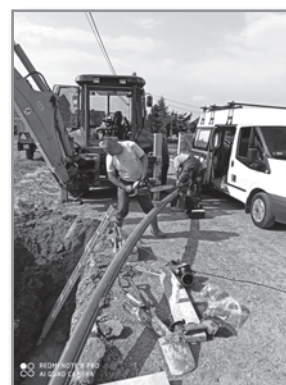
Budowa wodociągu ul. Kochanowskiego w Wilamowicach
