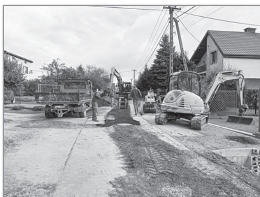
Budowa kanalizacji Dankowice
