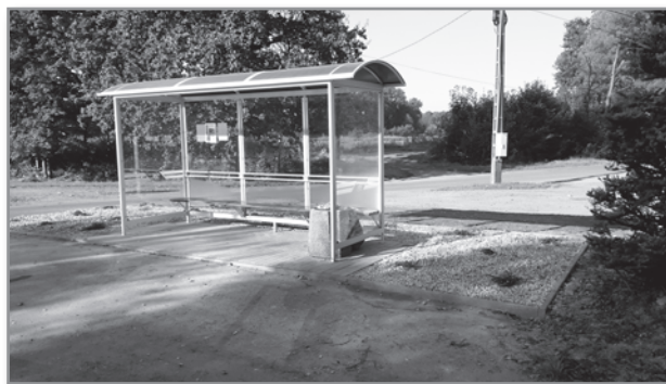
Nowy przystanek autobusowy z zagospodarowaniem terenu wokół Pisarzowice Krzemień
