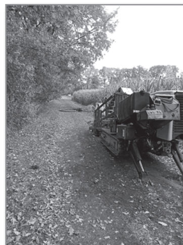
Budowa wodociągu w rejonie ul. Wrotnowskiej w Zasolu Bielańskim
