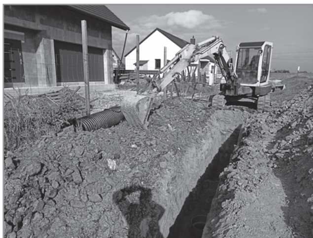
Budowa kanalizacji w rejonie ul. Nowy Świat w Zasolu Bielańskim
