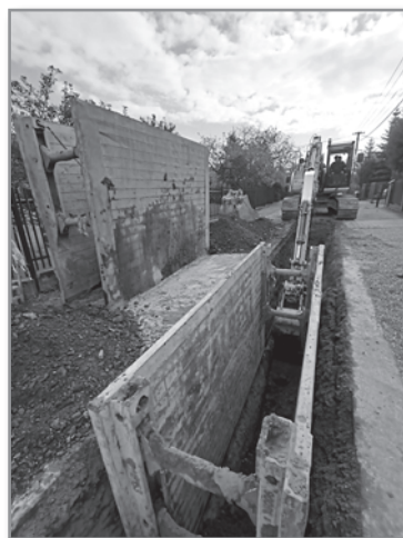
Budowa kanalizacji w Dankowicach
